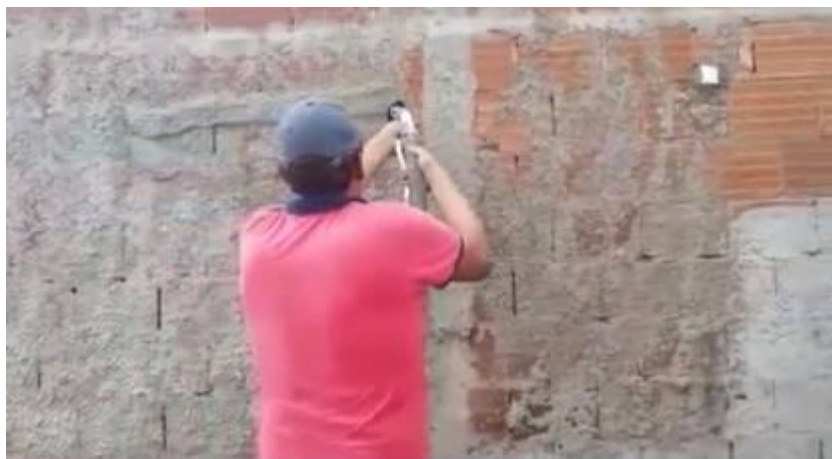
FIGURA 11 – Máquina de projetar reboco em uso.
