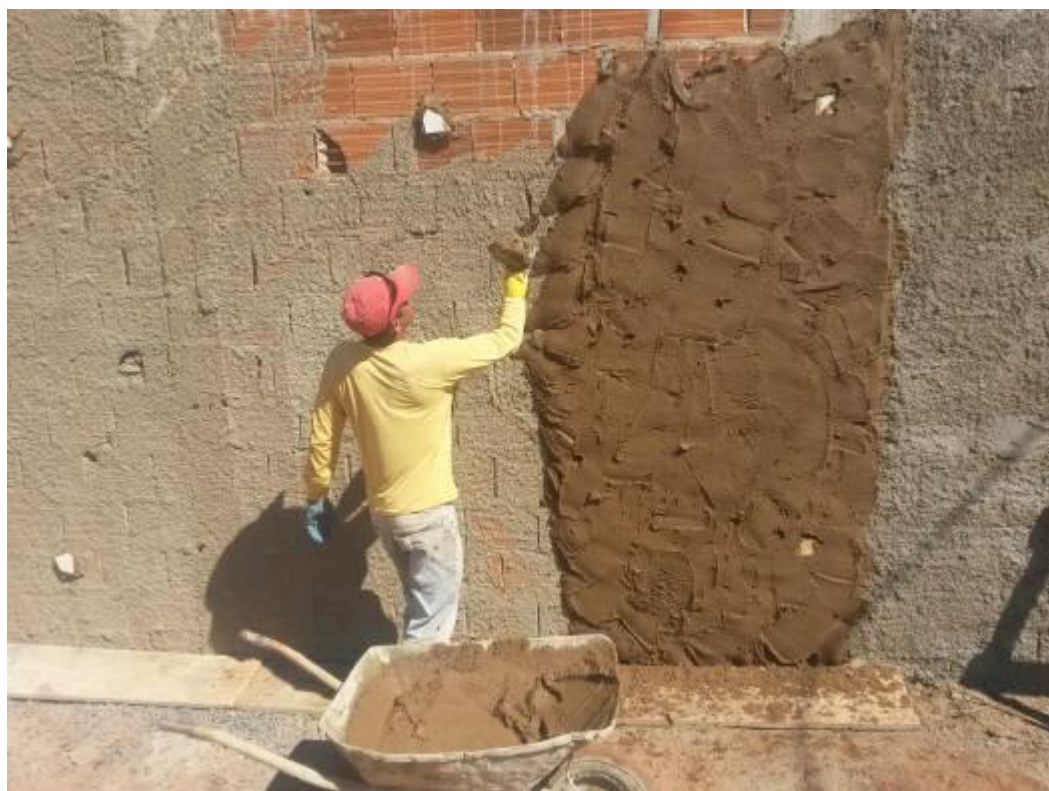
FIGURA 10 - Modo tradicional de reboco.
